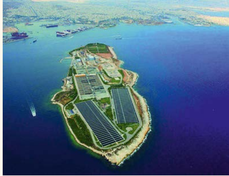
Die Athener Zentralkläranlage auf der Insel Psyttalia wurde 1994 gebaut und ist die zweitgrößte ihrer Art in Europa. Foto: Gina Stefanakou, Athens Water Supply and Sewerage Company (EYDAP S.A.)
