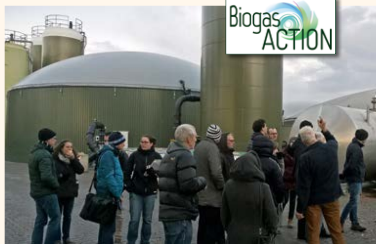
— Besichtigung einer Biogasanlage im niederländischen Beltrum während des Projekttreffens im November 2017.
