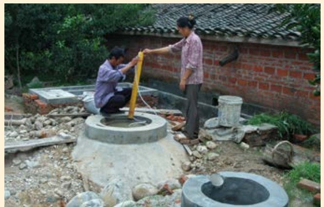
■ Bau eines Fermenters in China im Rahmen des Sichuan-Haushaltsbiogasprogramm. Werkfoto
