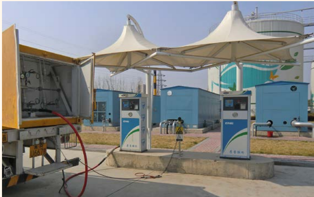
■ Endprodukt nach der Reinigung und Aufbereitung des aus dem Stroh-Gülle-Gemisch entstandenen Biogases ist CNG, das dann in Tankwagen abtransportiert, weiterverteilt und als Kraftstoff verwendet wird. Werksfotos
