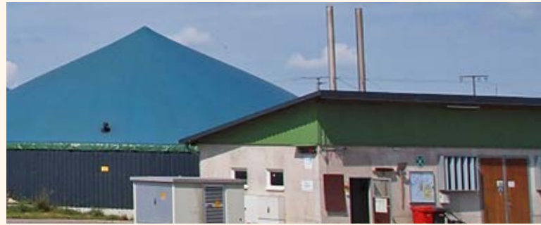
■ BHKw-Aufstellraum an einer nach 4. BImSchV genehmigungsbedürftigen Biogasanlage. Deutlich zu erkennen sind die beiden Schornsteine. Foto: FnBB e.V.
