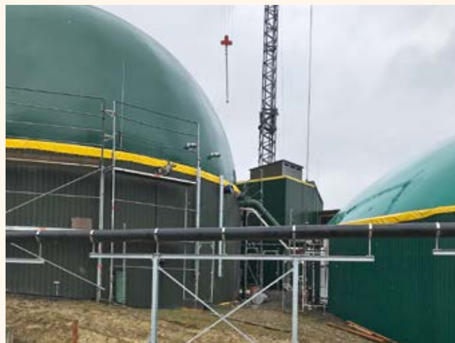
Impressionen von den Baumaßnahmen.
